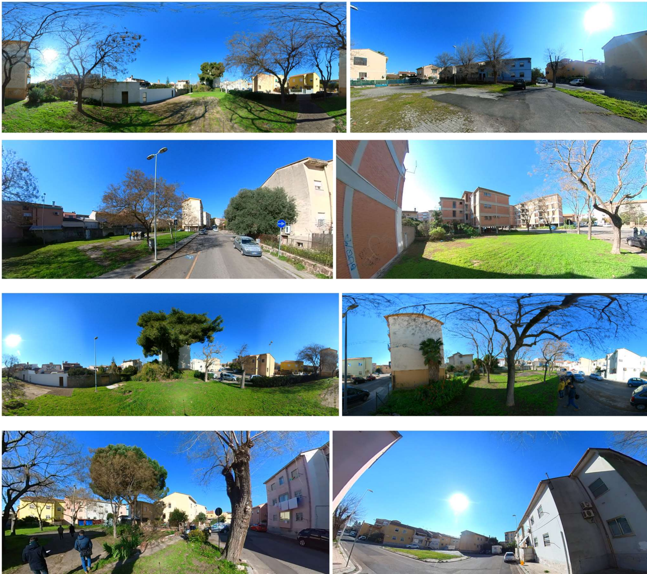
Figura 3 – Stto di fatto delle aree oggetto di riqualificazione
