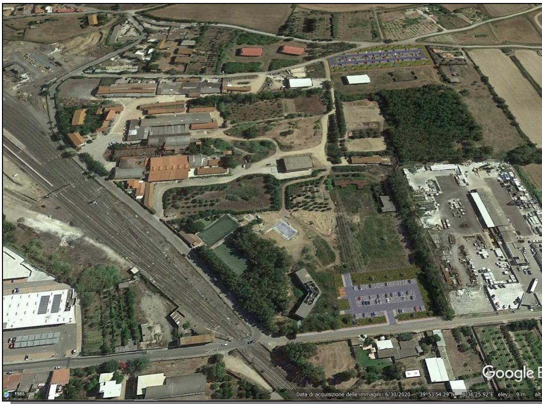
inquadramento generale - situazione ante e post intervento (Foto Google Earth)
