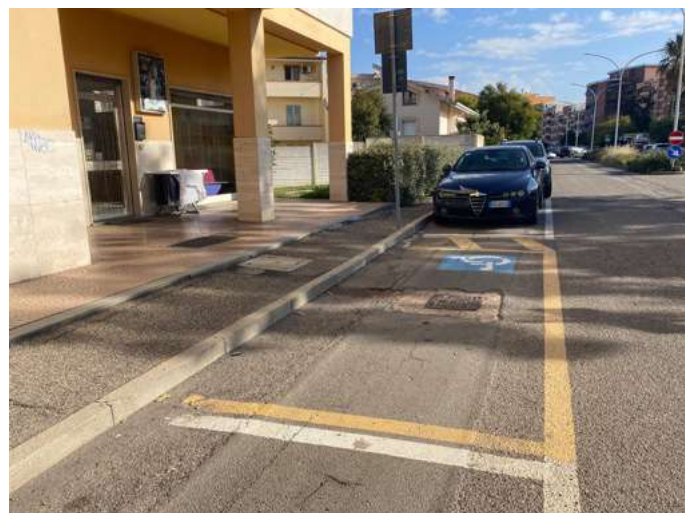
Stallo riservato, assenza raccordi
