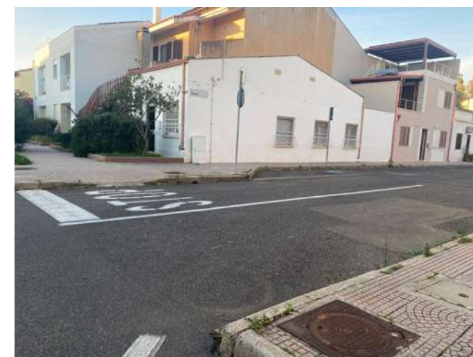
Incrocio Via Amalfi, Via Capo Teulada e Via Genova, assenza continuità percorso pedonale e raccordo
