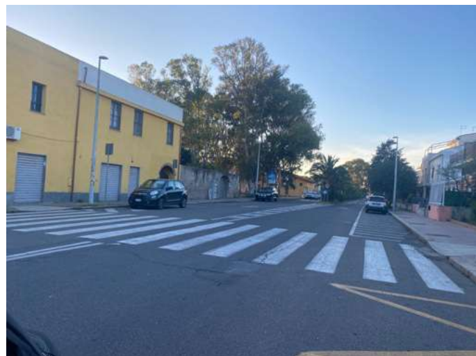
Via Millelire lato destro Torre, primo attraversamento, insicurezza per lunghezza eccessiva
