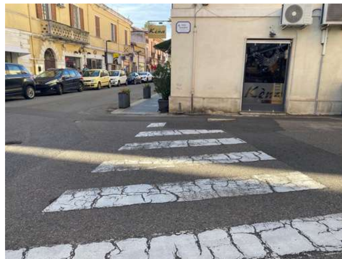
Incrocio Vico Mazzini, assenza continuità pedonale lato ristorante
