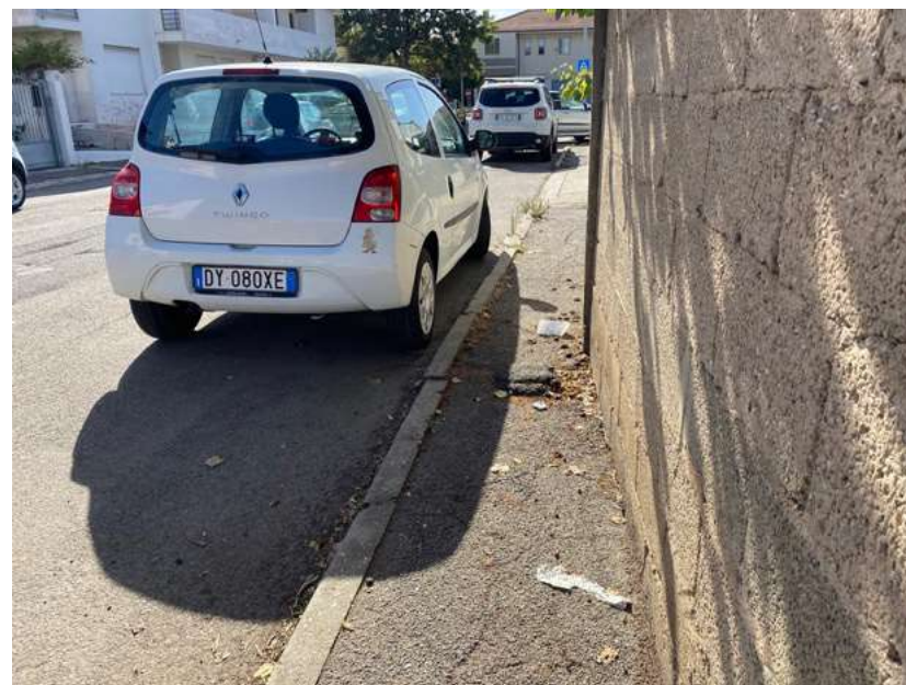
Marciapiede lato ovest, restringimento passaggio < 90 cm
