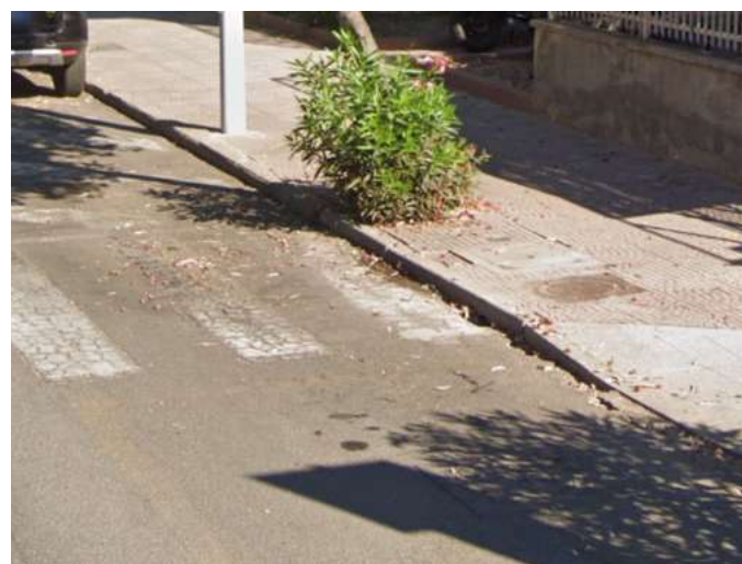
Attraversamento n°4 dopo via dei Catalani, assenza raccordo in prossimità delle zebre
