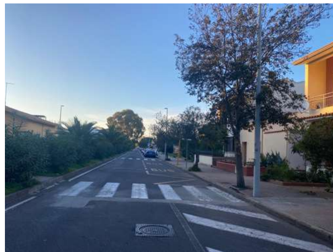
Attraversamento n°2, assenza raccordi
