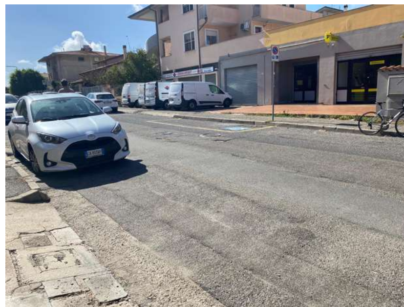
Fronte Poste, assenza attraversamento pedonale
