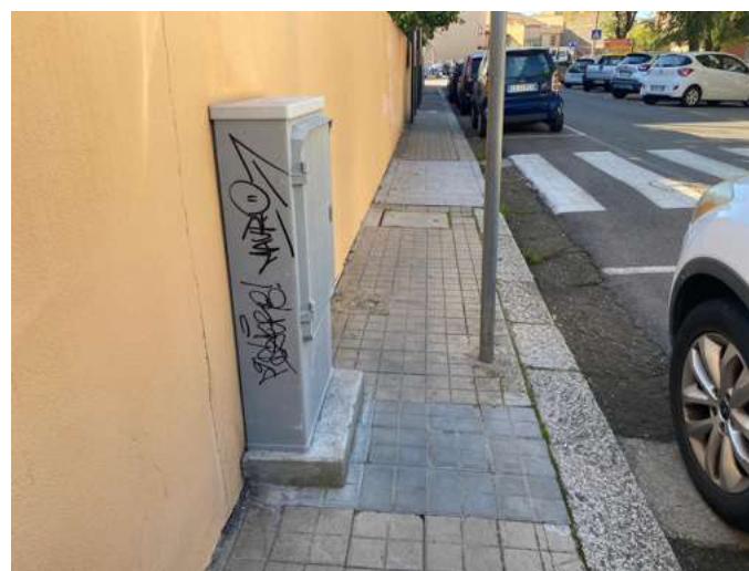
Attraversamenti pedonali Via Bellini, assenza raccordi e restringimento passaggio pedonale marciapiede
