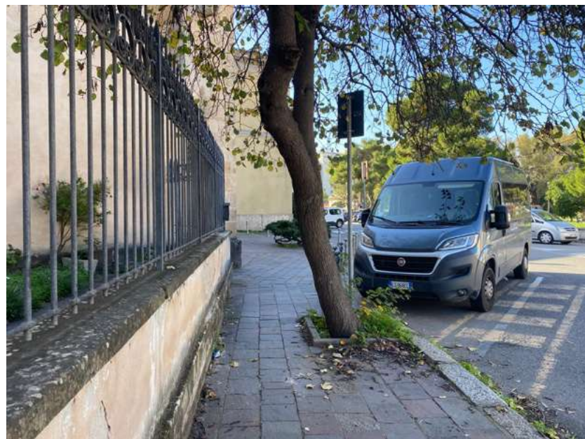
Marciapiede Piazza San Martino lato sud, interruzione continuità percorso pedonale e assenza segnaletica
