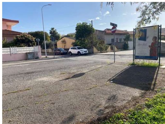
Piazzale Gennargentu-Petri, assenza continuità percorso pedonale
