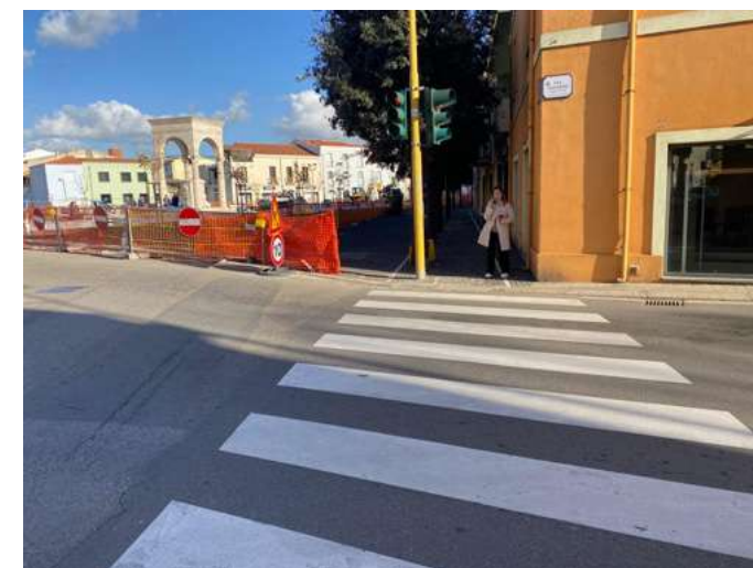
Attraversamento Via Solferino, insicurezza per assenza chiamata e cicalino impianto semaforico
