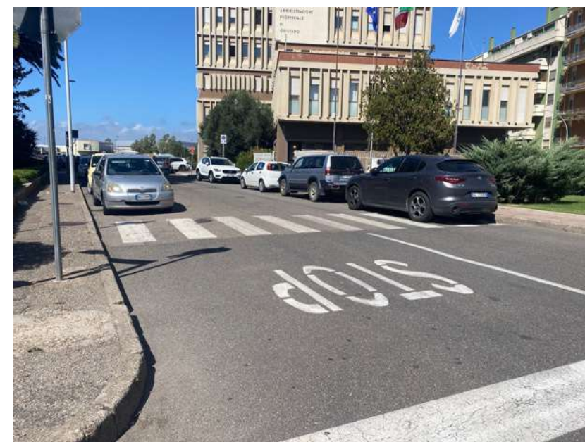
Incrocio via Carboni, assenza raccordo
