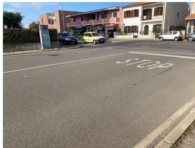
Incrocio via Limbara, assenza continuità percorso pedonale
