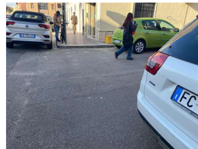
Incrocio Vico Mariano, assenza continuità pedonale e raccordi
