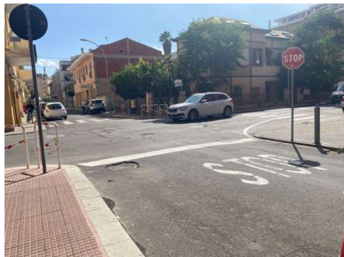
Incrocio via XX Settembre, assenza raccordi e assenza continuità lato ovest
