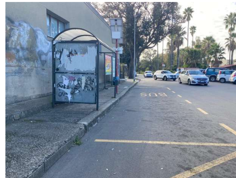
Fermata bus lato sud, assenza raccordo al percorso
