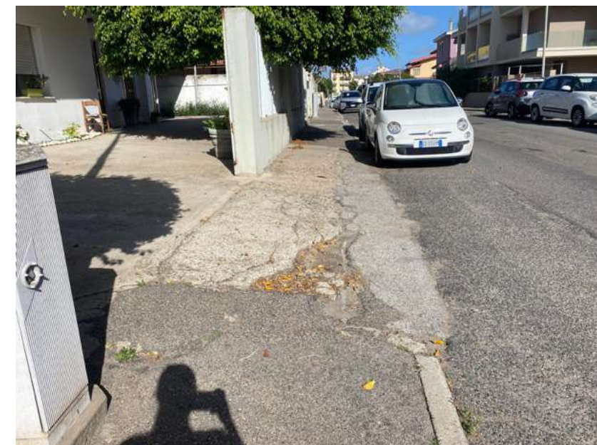
Presso num civici 1- 11- 13- 13a- 17-27-33, pavimentazione sconnessa in prossimità del passo carrabile
