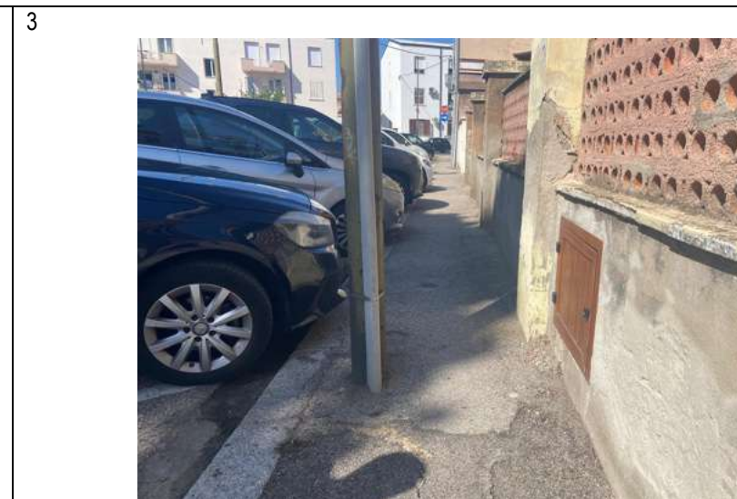
Marciapiede lato Est, interruzione lampione con restringimento percorso a 78 cm
