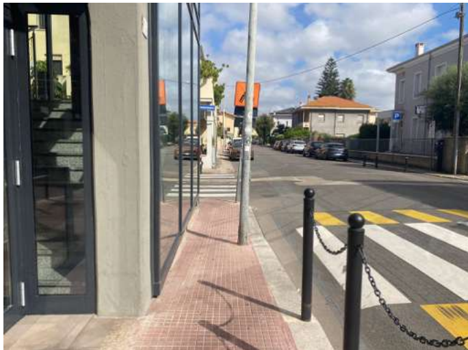
Incrocio Via Cavour marciapiede lato ovest, passaggio < di 90 cm per presenza lampione
