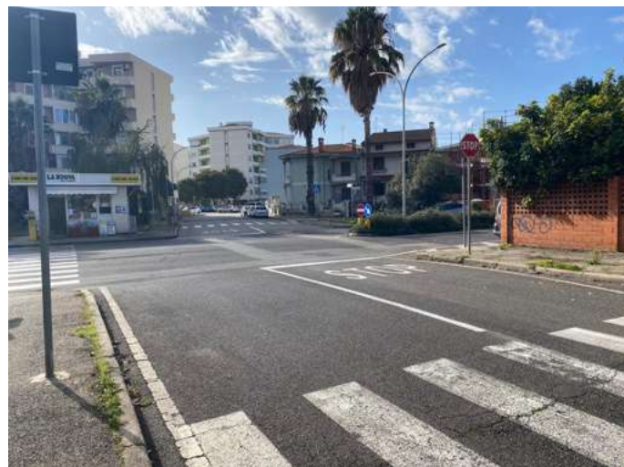
Attraversamento incrocio via Merenzio, assenza raccordi
