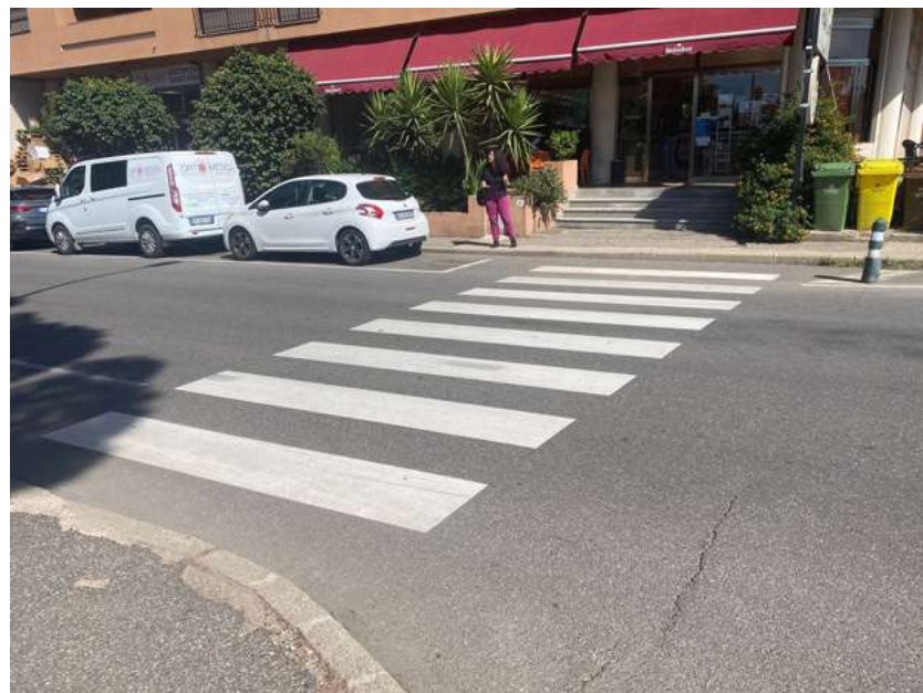
Attraversamento pedonale incrocio Viale Diaz, assenza raccordi su gradini h 8 cm
