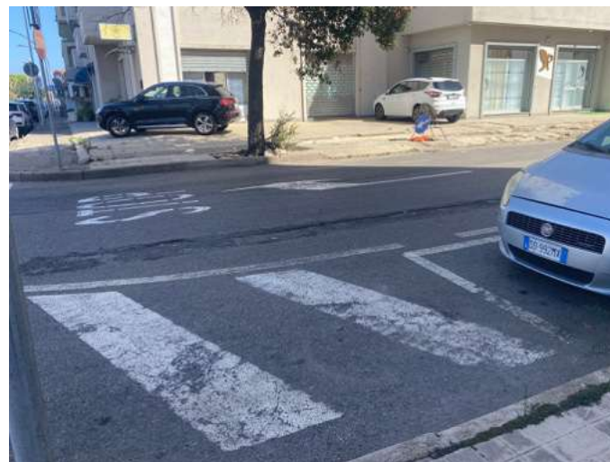
Incrocio via Einaudi, assenza continuità pedonale
