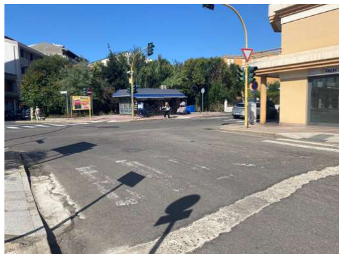
Incrocio via San Francesco, segnaletica orizzontale inadatta
