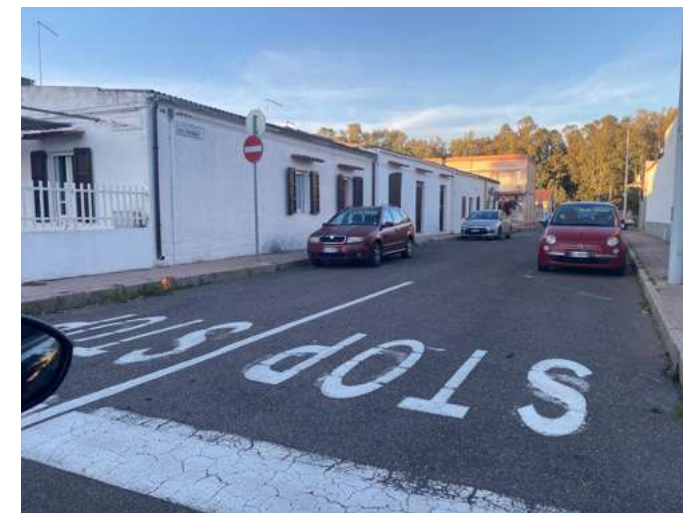
Incrocio Via Dei Catalani lato nord, assenza continuità pedonale e raccordi
