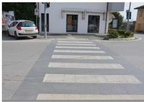
*Vernice con microsfere rifrangenti e semaforizzazione*
