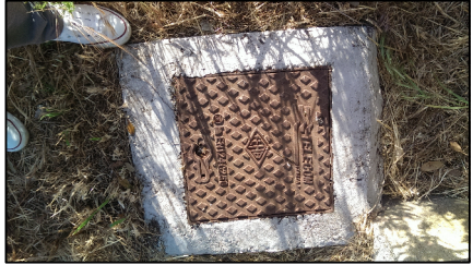
Foto 6 - pozzetto idroelettrico
