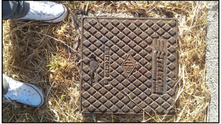
Foto 6 - pozzetto accumulo ENEL
