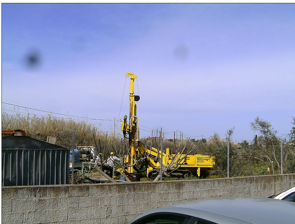
Postazione sondaggio a carotaggio continuo S 5
