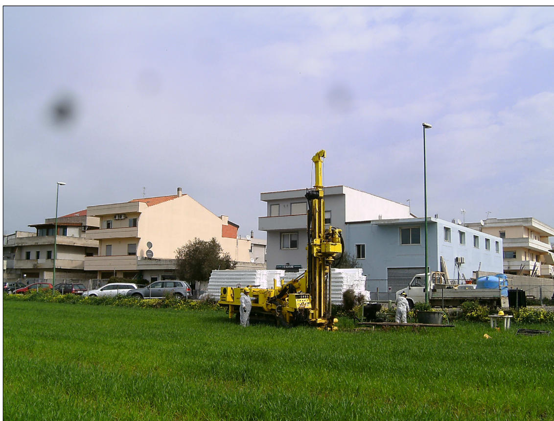
Postazione sondaggio a carotaggio continuo S 2
