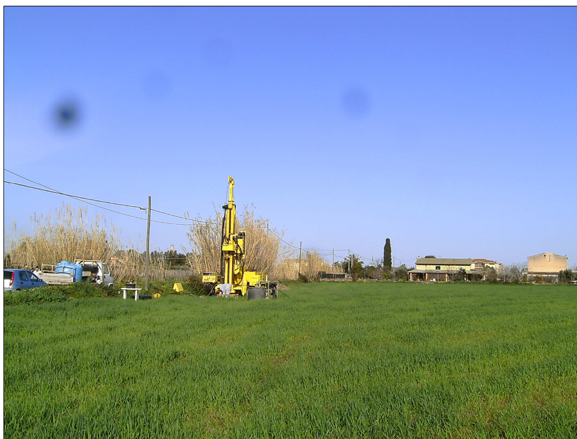
Postazione sondaggio a carotaggio continuo S 4
