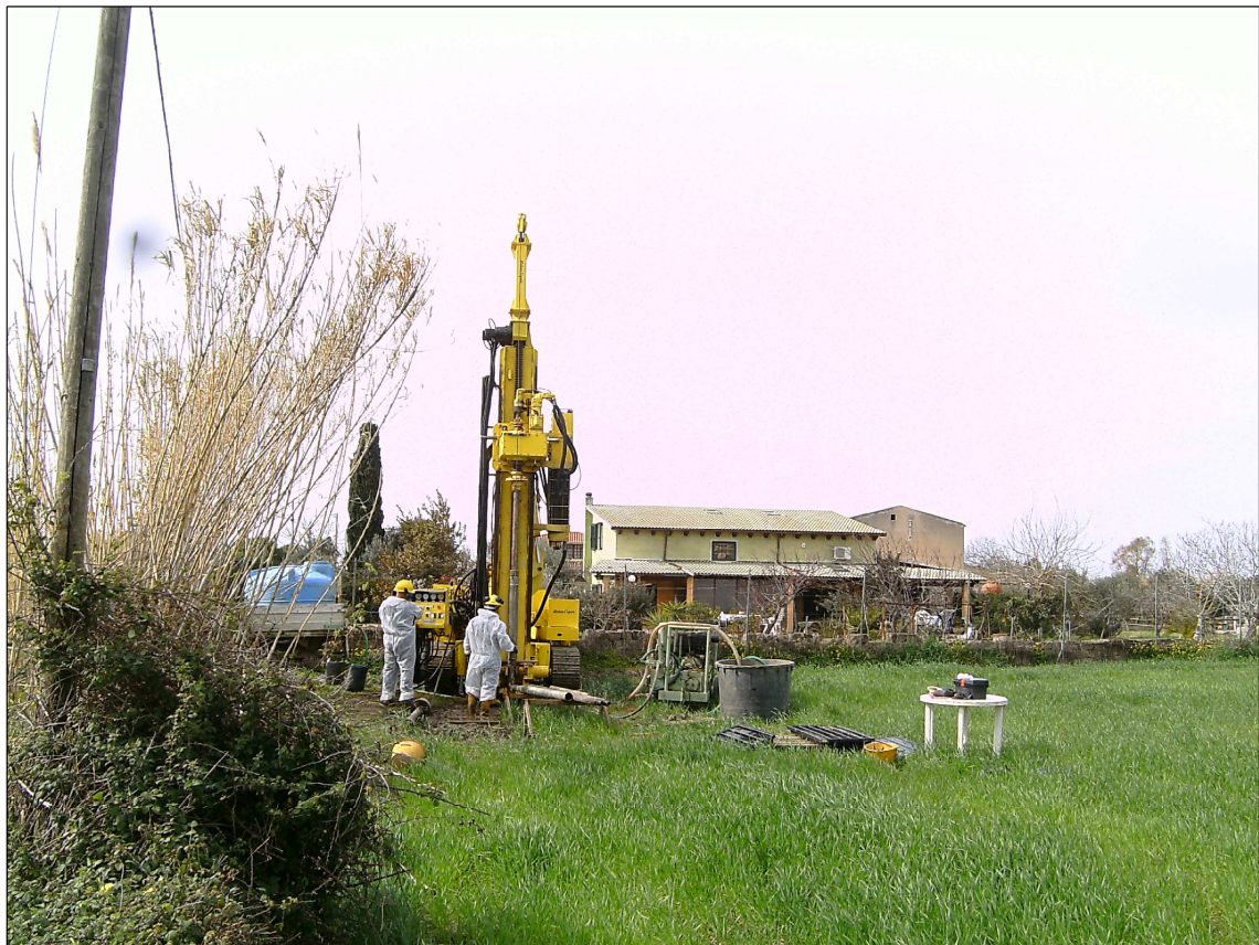
Postazione sondaggio a carotaggio continuo S 3
