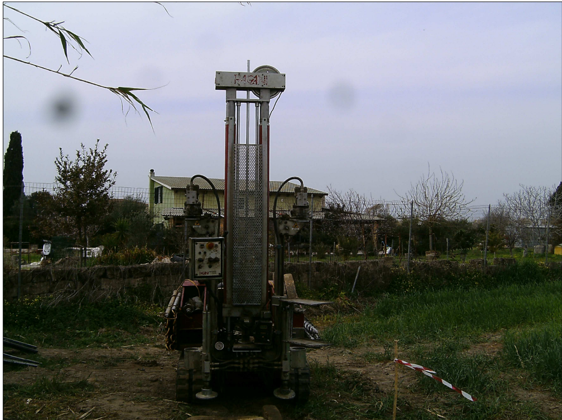
Prova Penetrometrica CPT 1
