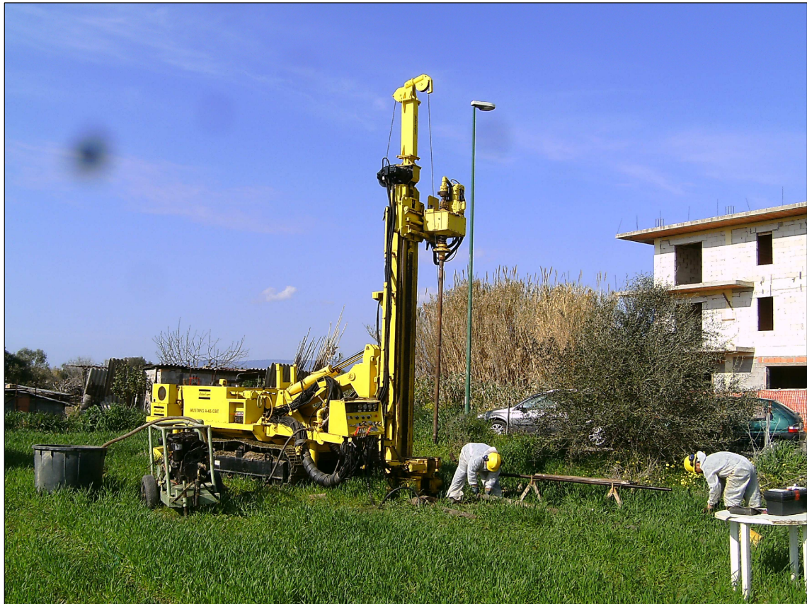
Postazione sondaggio a carotaggio continuo S 1
