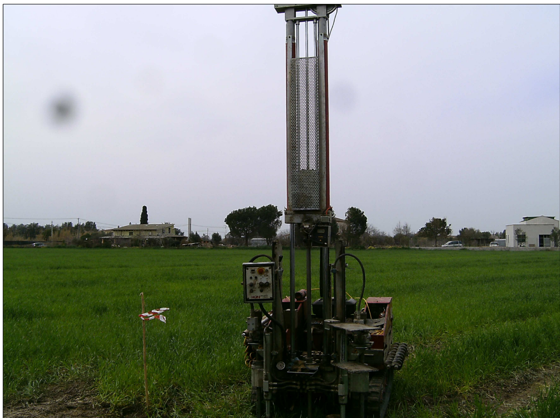
Prova Penetrometrica CPT 2
