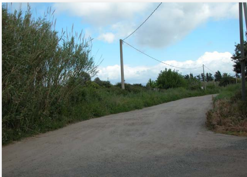
Foto stato attuale vista n. 1
