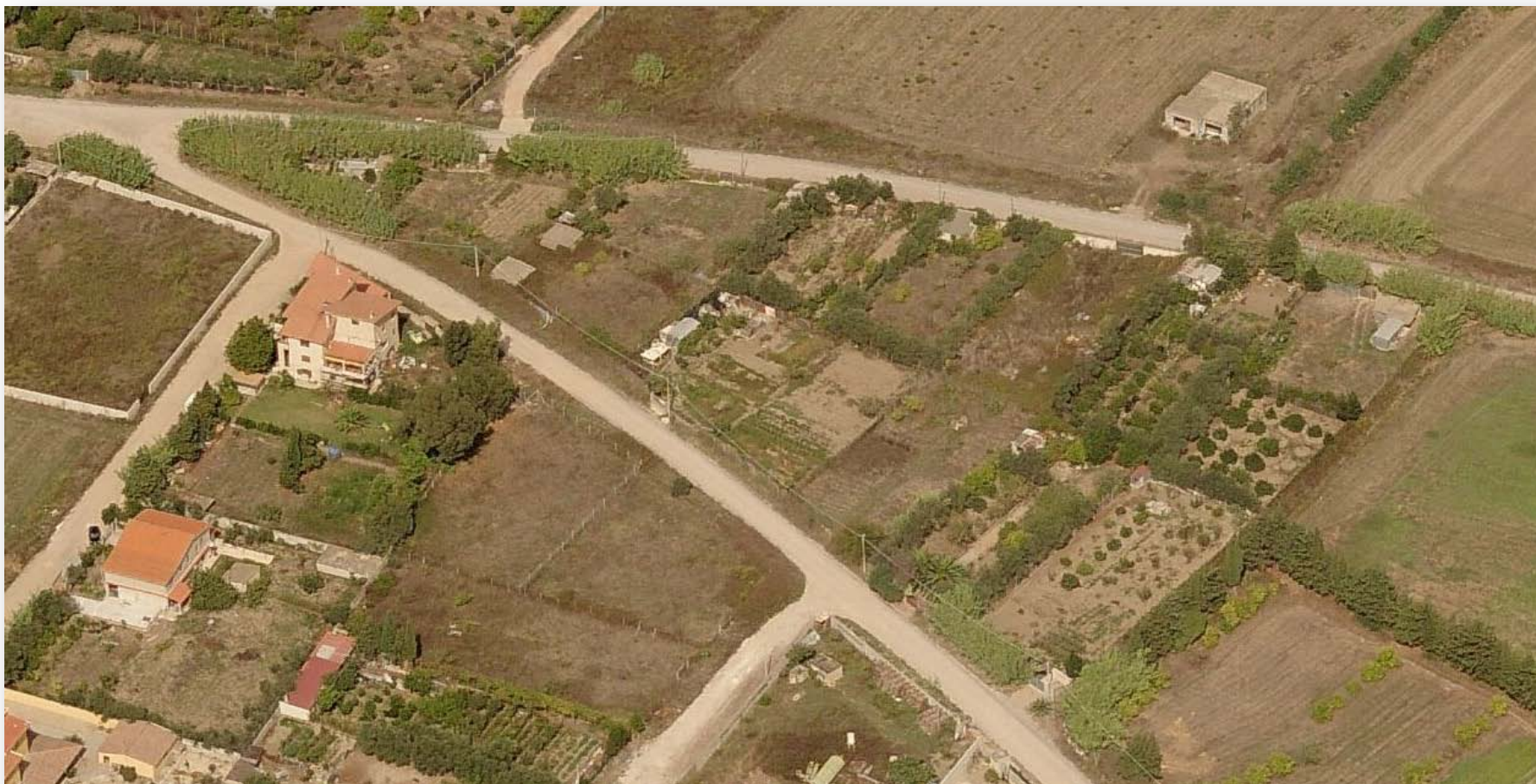
Immagine aerea stato attuale.
