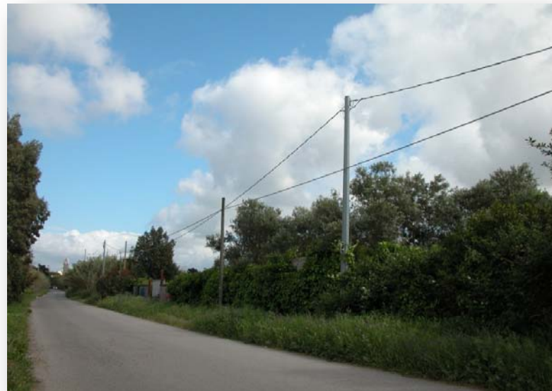
Foto stato attuale vista n. 5
